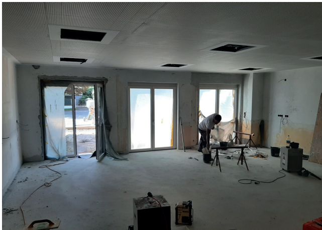
Der Bau eines neuen Klassenraums wurde baulich vorgezogen
