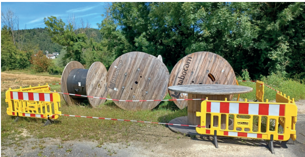
Km von Glasfaserkabeln wurden bereits verlegt
